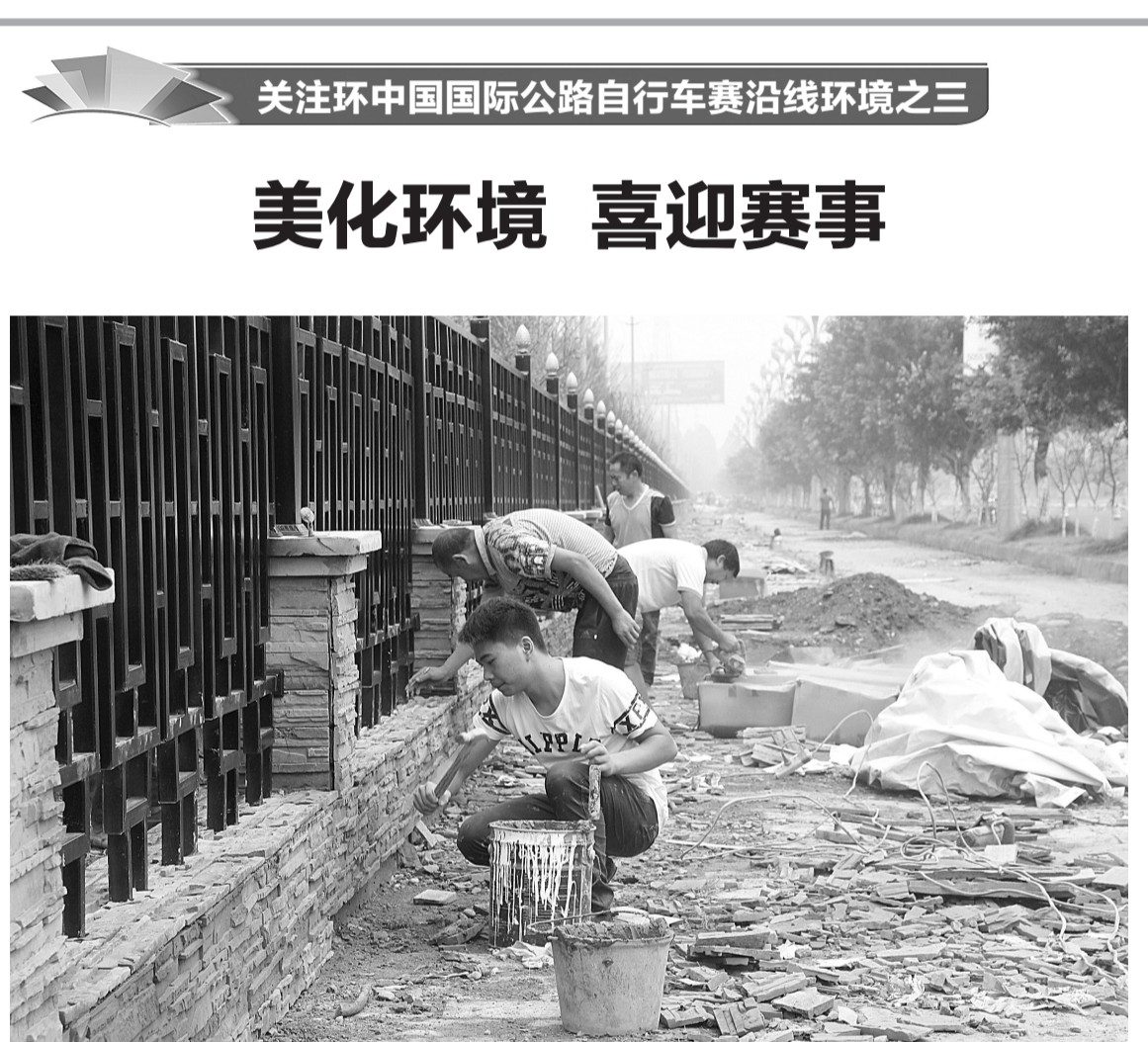
峨眉山市秀湖大道改造围栏及人行道工程抓紧施工
