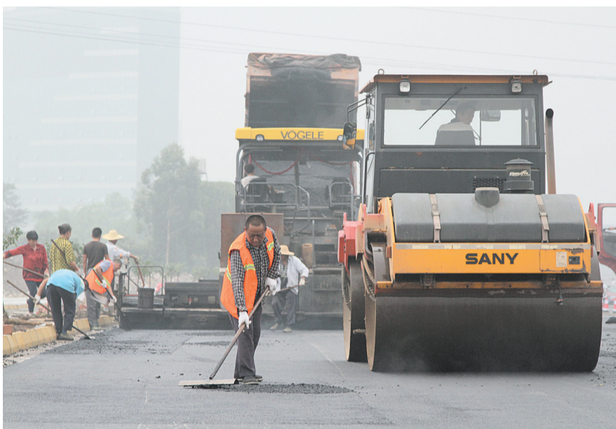
金顶大道施工现场
