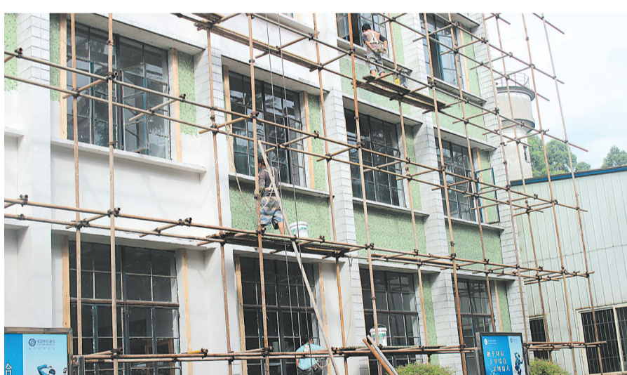
工人加紧对房屋进行风貌塑造
