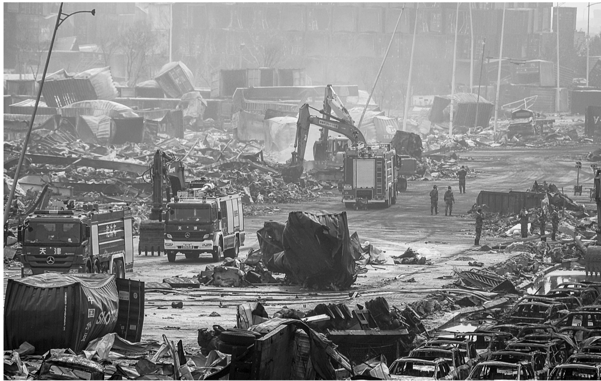
8月17日,救援人员在爆炸现场使用工程机械清除障碍。
