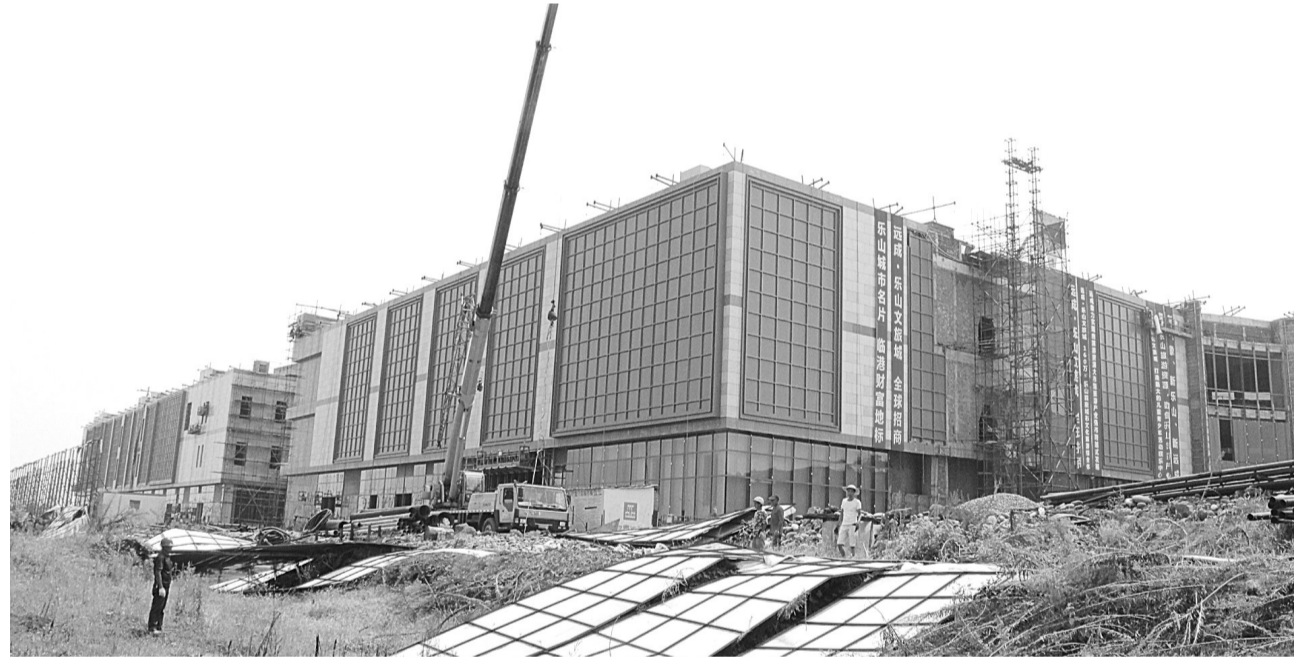
机械臂正在对工地围板进行吊运拆除
