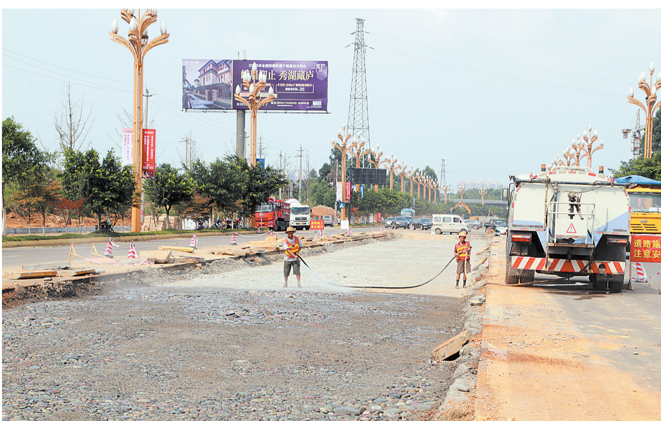
彭桥高速出口扩建项目建设现场
