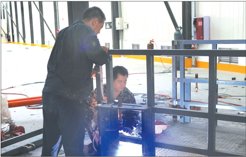
乐山高新区三八物流项目工人抓紧设备安装
