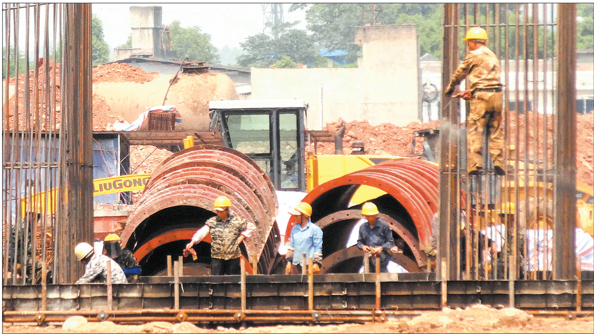
乐峨快速通道建设者在烈日下施工
