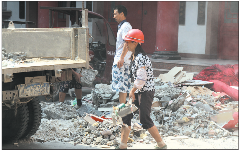
建筑工人清理建筑废料
