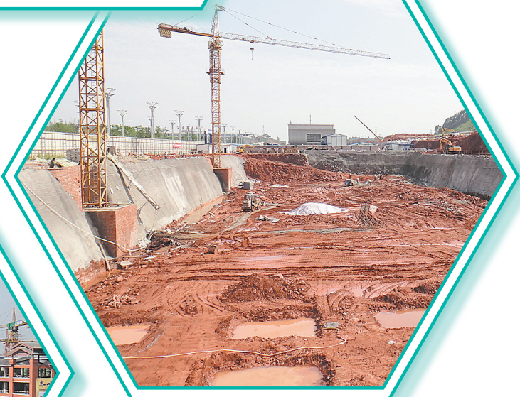
旅游集散中心已完成基坑开挖
