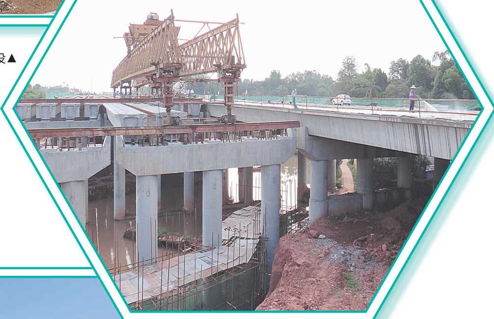
嘉瑞大道石板滩大桥建设现场
